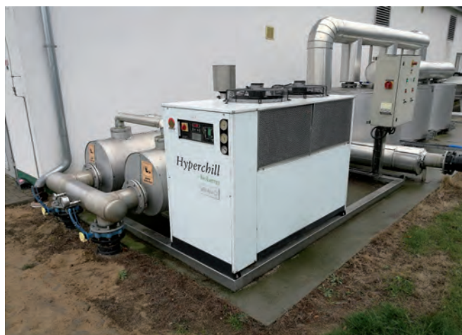
System osuszania biogazu w jednej z biogazowni rolniczych.
