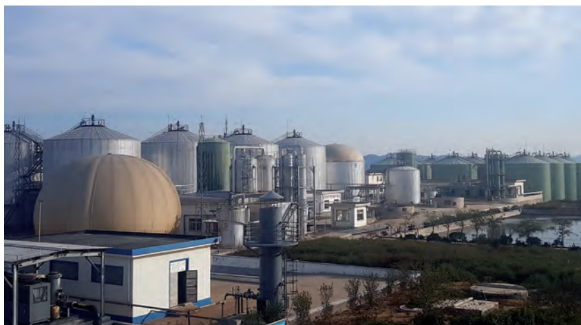
Fot. 1. Biogazownia na pomiot 1000 t na dobę.
