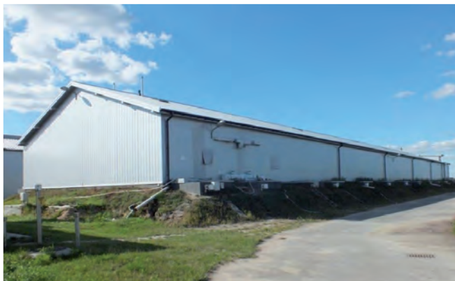
Fot. 3. Biogazownia ProBioGas w Międzyrzeczu Podlaskim.
