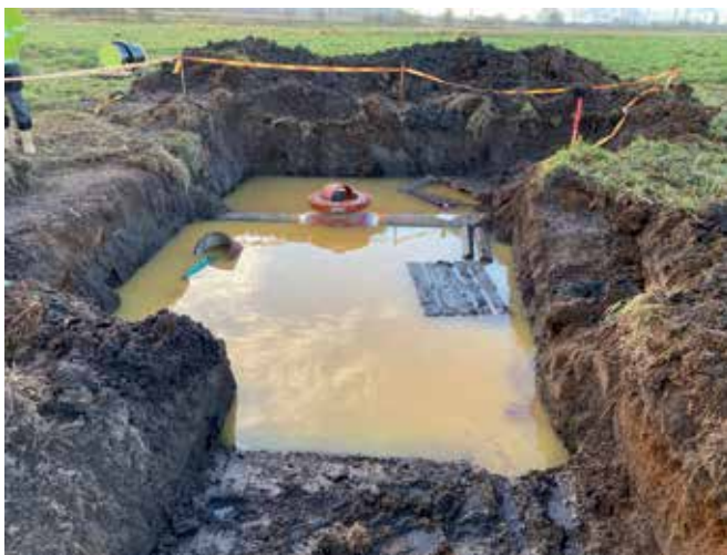
Fot. 6. Odslonięty fragment gazociągu istniejącego na zachodnim brzegu.
