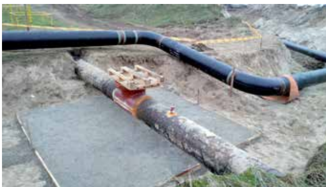
Fot. 7. Odslonięty fragment gazociągu istniejącego na wschodnim brzegu.
