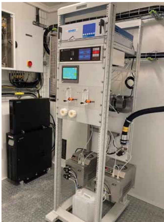
Wnętrze kontenera analizatorów – układ kondycjonowania wraz z analizatorami gazowymi.
