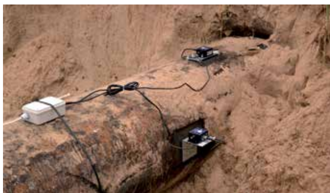
Fot. 10. Zdjęcie zamocowanych inklinometrów w części podporowej odsłoniętego gazociągu na brzegu wschodnim.
