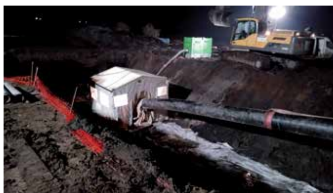
Fot. 5. Etap wciągania gazociągu.
