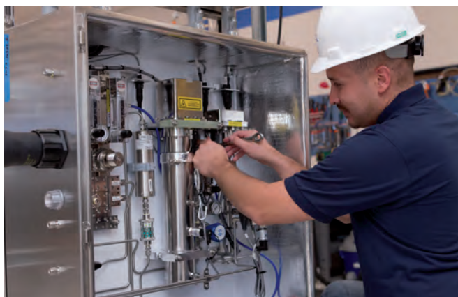
Zdjęcie 1. Analizator SpectraSensors SS2100 w trakcie instalacji.
