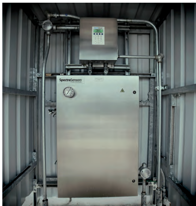
Zdjęcie 2. Analizator wilgoci w gazie ziemnym z systemem kondycjonowania próbki.
