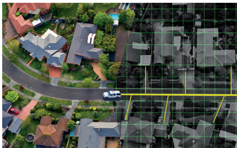
Automatyczna lokalizacja i klasyfikacja wykrytych wycieków.
