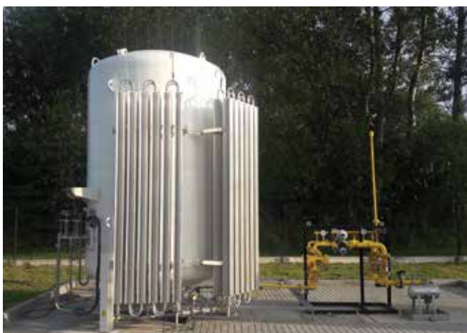
Zdjęcie 3. Mała stacja regazyfikacji LNG po zakończeniu prac.
