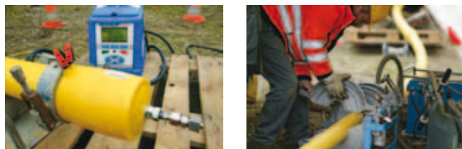
Fot. 1. Zgrzewanie elektrooporowe i doczołowe rur z poliamidu PA12 (VESTAMID®NRC).
