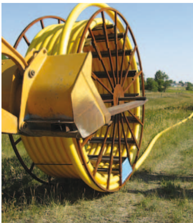
Fot. 2. Budowa gazociągu z rury PA12 (VESTAMID®NRC) odwijanej z bębna.
