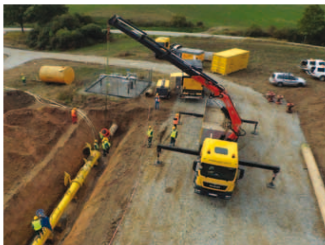
Rysunek 2. Instalacja tymczasowej komory inspekcyjnej
