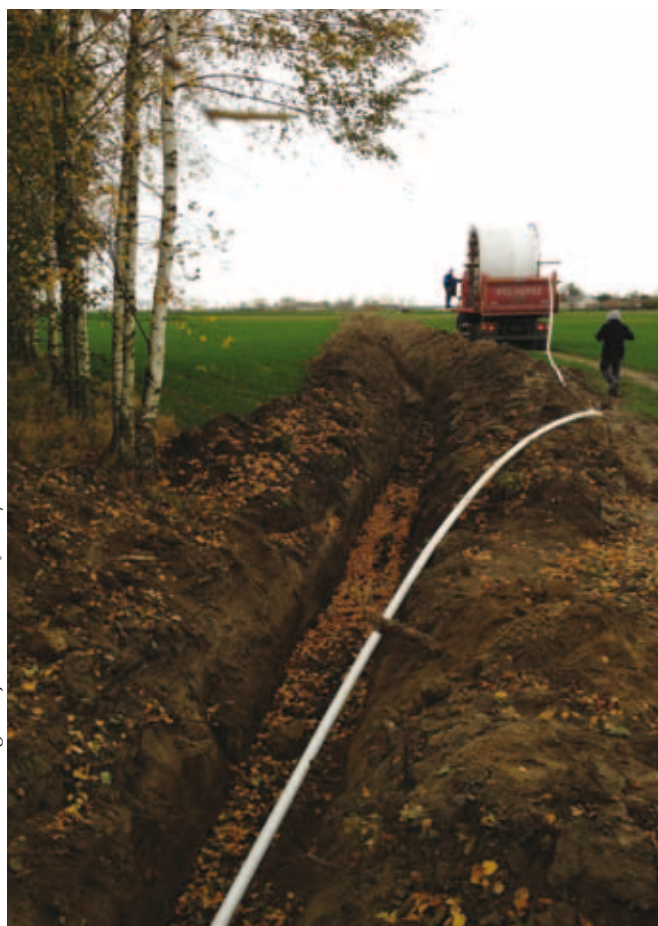
Fot. 4. Układanie w wykopie otwartym rurociągu z rur wzmocnionych włóknami aramidowymi.
