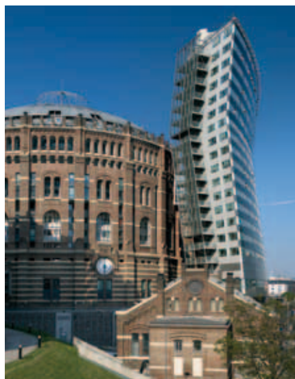
Gasometer B, © Duccio Malagamba, mat. pras. Coop Himmelb(l)au.
