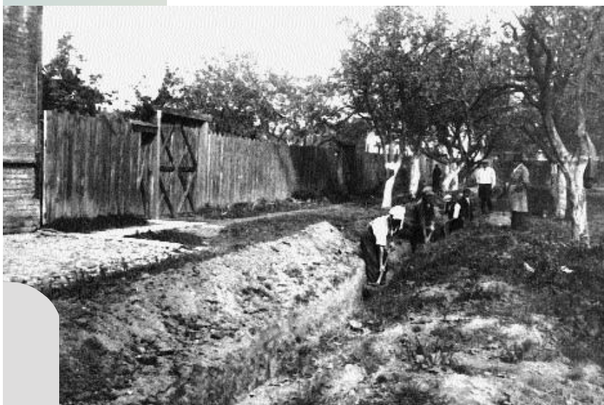
Budowa pierwszych gazociągów 1929 r.
