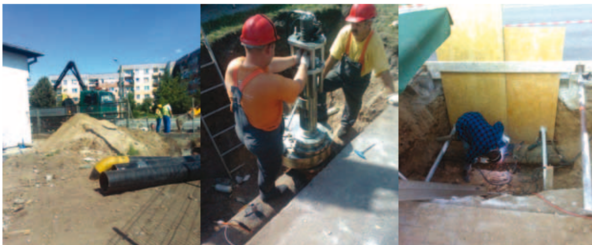
Adaptacja sieci gazowej do nowego rodzaju gazu na osiedlu Północ w Suwałkach.
