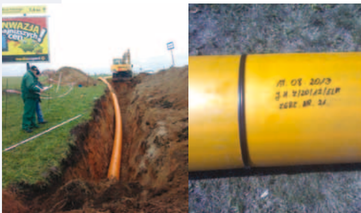
Rozbudowa sieci dystrybucyjnej w Suwałkach.
