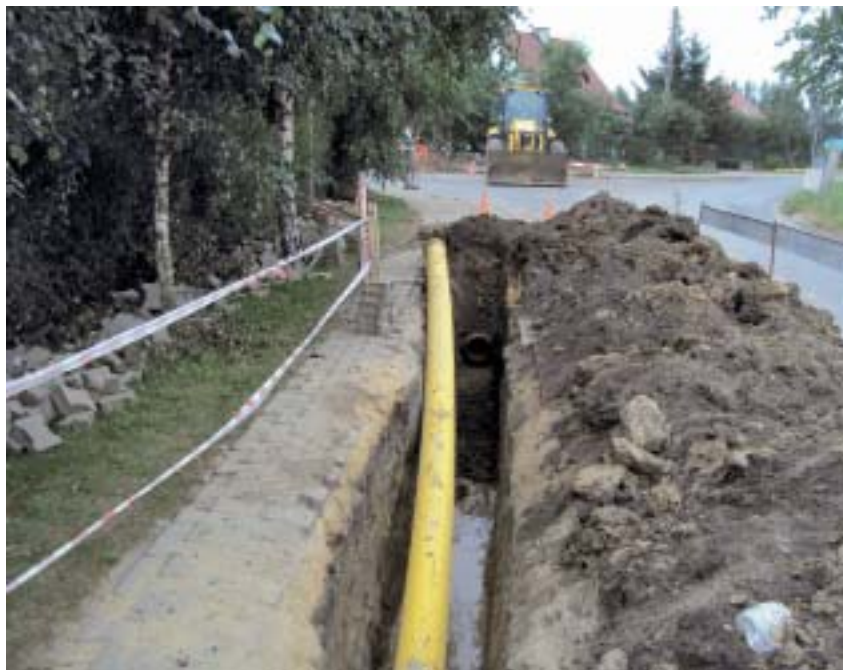
Układanie gazociągu w wykopie.
