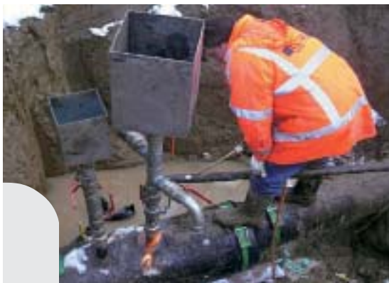
Rys. 2. Rury przygotowane do wtlóczenia masy.
