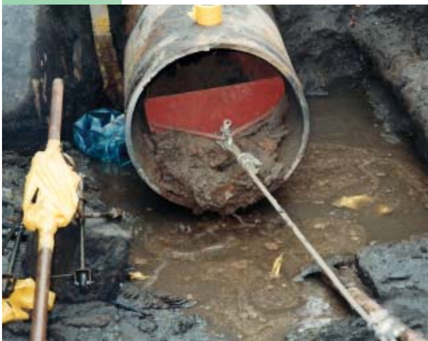
Wrocław, ul. Tęczowa. Czyszczenie gazociągu żeliwnego DN 470 pod relining.
