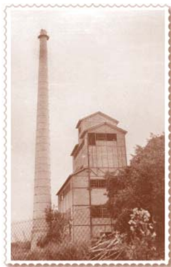
56-metrowy komin z galerijką (1960), wyburzony w 1992 r.
