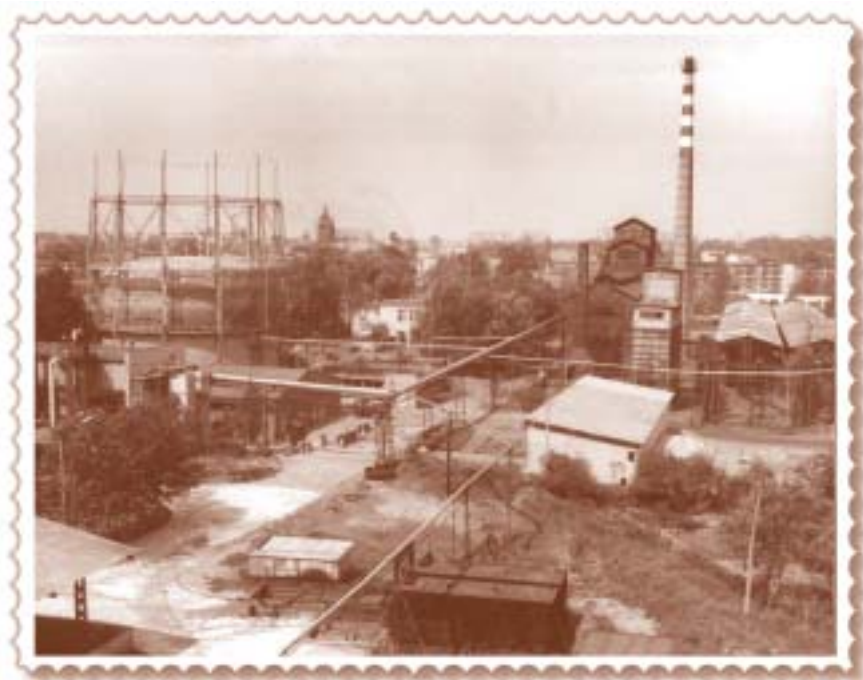
Gazownia po modernizacji, lata 70. ub.w.
