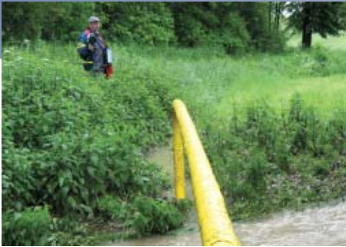
Kontrola w miejscu napowietrznego przekroczenia gazociągiem przeszkody terenowej.
