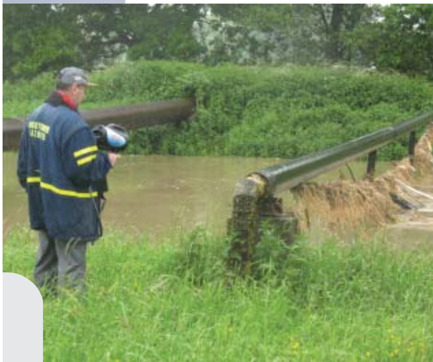
Kontrola sieci w miejscu przejścia gazociągu przez rzekę.
