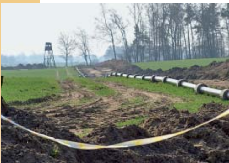
Budowa gazociągu Trzemeszno–Witkowo.
