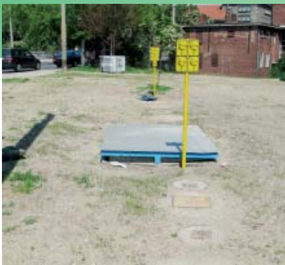
Widok ogólny stacji podziemnej i jej otoczenia
