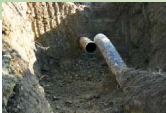
Przesunięcie uszkodzonego gazociągu.
