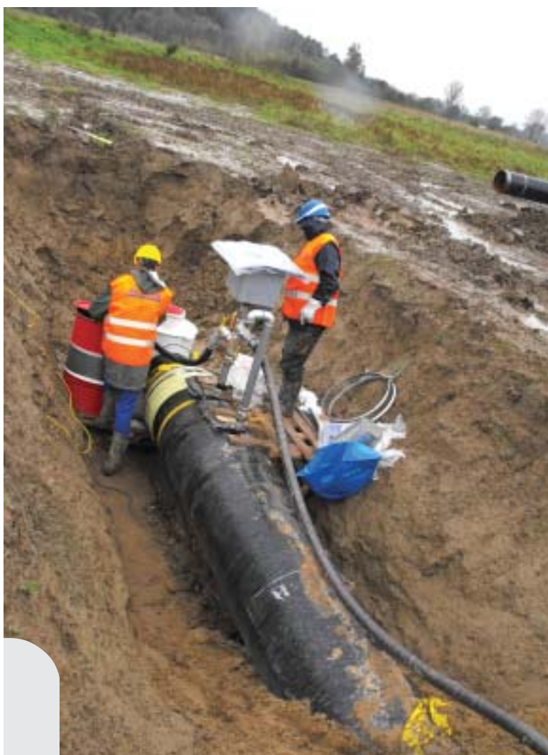
Zamknięcie rury osłonowej wg schematu.
