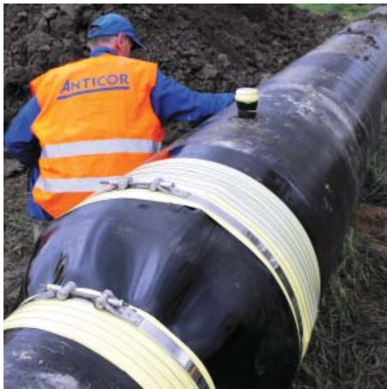
Zabezpieczenie gazociągu w/c DN 500 dł 96 m.
