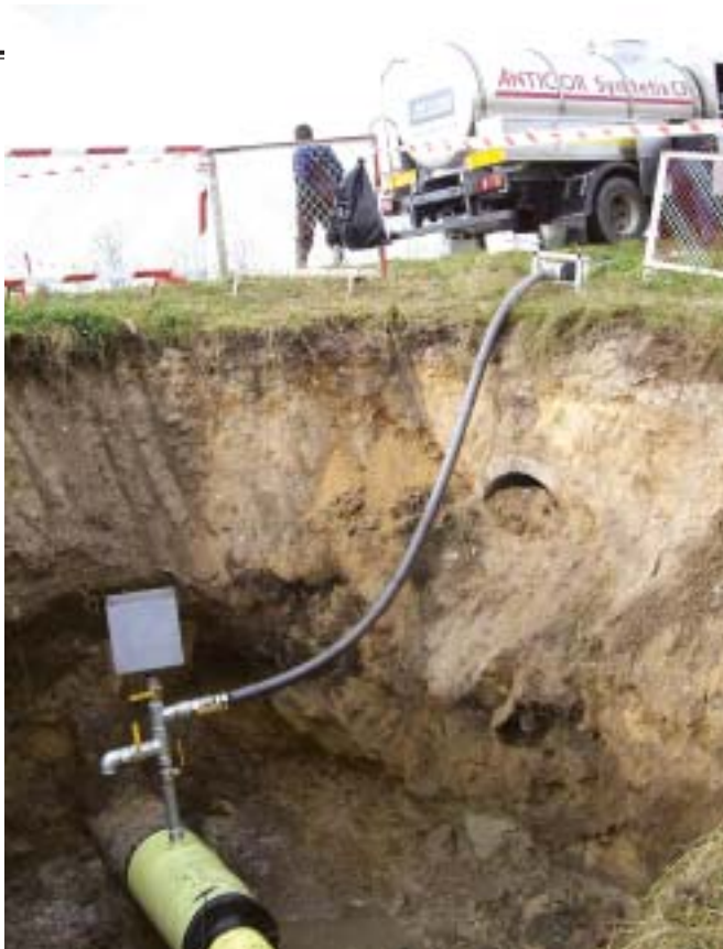
Przygotowany system króćców do wtłoczenia materiału Anticor Syntetix CF.
