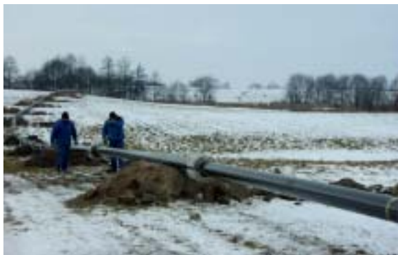
Prace przy montażu gazociągu.
