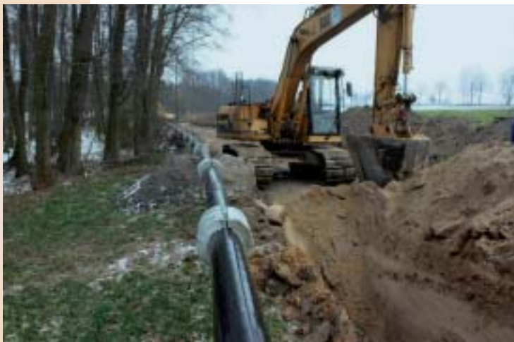
Odcinek gazociągu z rur pokrytych laminatem żywicznym, przygotowany do przewiertu kierunkowego.
