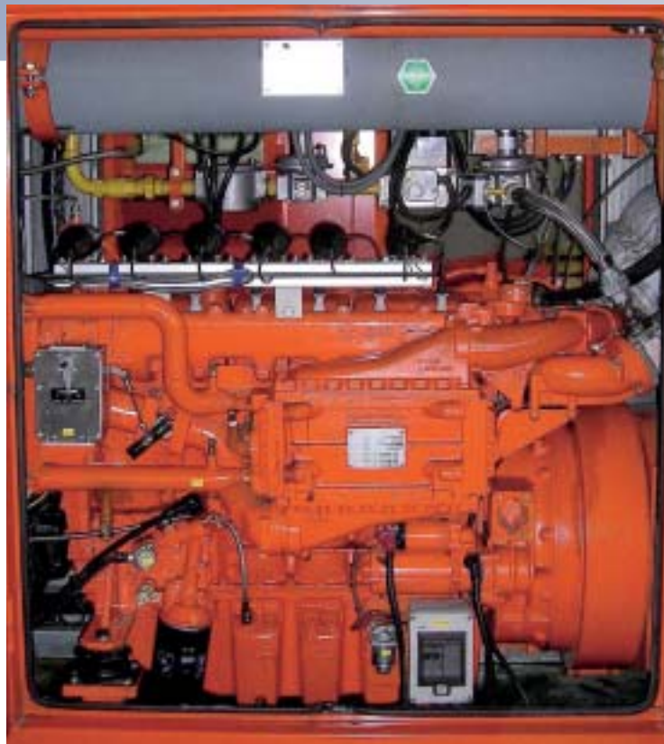
Silnik gazowy model E0836 LE 202 firmy MAN.
